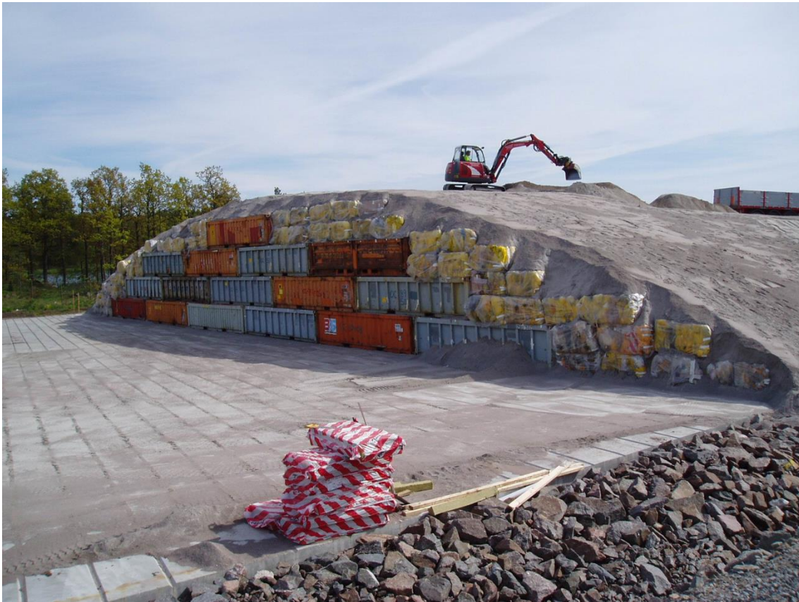
Figur 8. Markförvaret byggs upp av en hård kärna med containrar i trappstegsform som byggs på med sopbalar av komprimerat avfall (foto från tidigare deponeringskampanj vid MLA2), OKG 2014.
