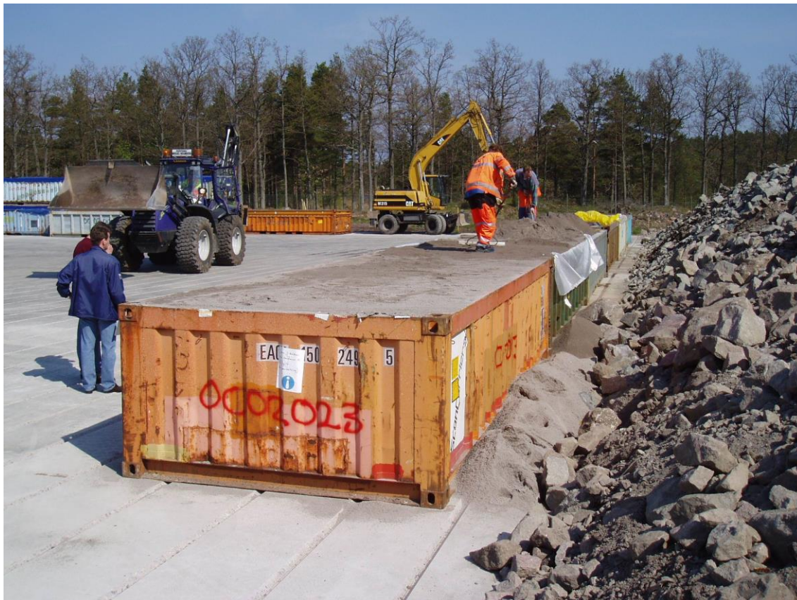
Figur 7. Stenmjöl fylls i varje container för att minimera luftfickor och skapa stabilitet över tid. Ytorna jämnas till (foto från tidigare deponeringskampanj vid MLA2), OKG 2004.
