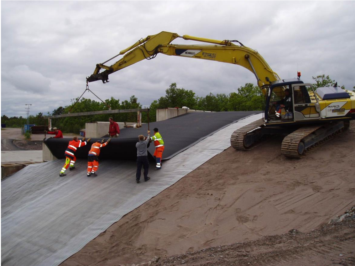
Figur 10. En bentonitmatta samt en polyetenmatta läggs över deponin som ett tätskikt (foto från tidigare deponeringskampanj vid MLA2), OKG 2004.
