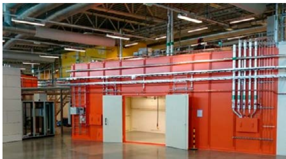
Figur 1. MAX IV har valt designlösningen med orangemålat strålskydd (väggar med betong och bly).
