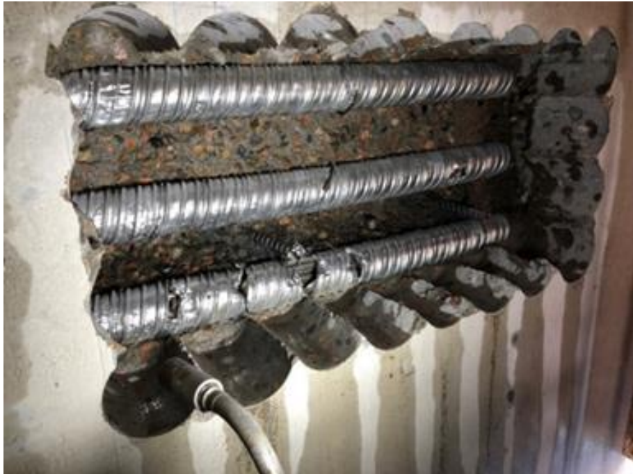
Frambilning av foderrör genom sömborring och vattenbilning
