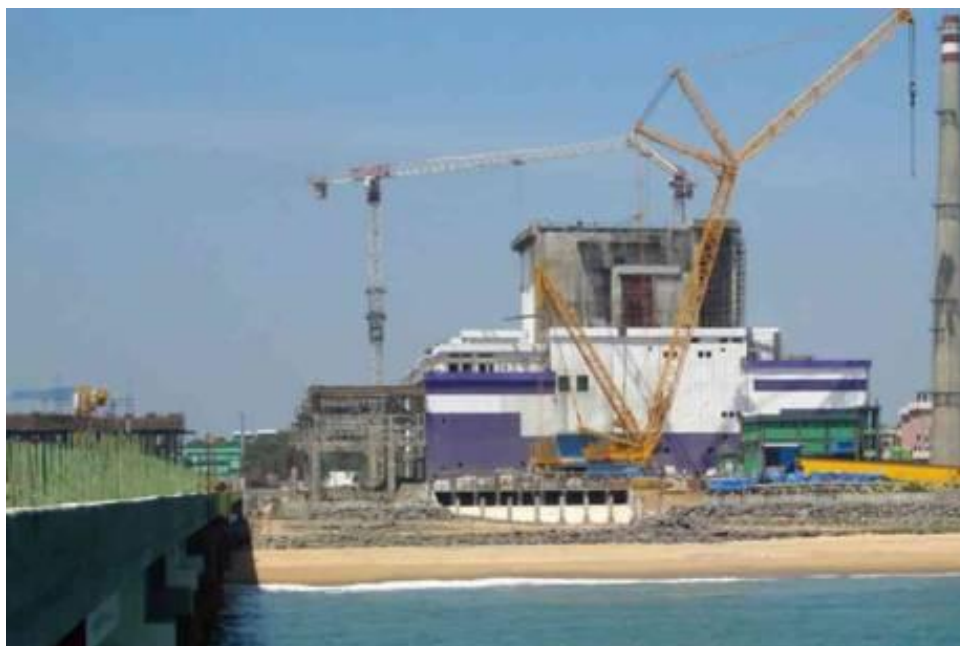
Figur 6: Den första PFBR-reaktor under uppförande i Kalpakkam.
