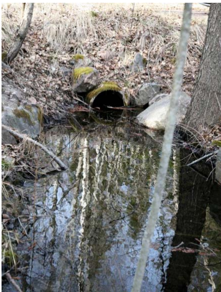
Figur 5-2. Tjärnpussens nuvarande utlopp i dess norra del (se översiktskartan i figur 1-1). Utloppet består av en betongtrumma (som utgör tröskel) under en gång- och cykelväg.
