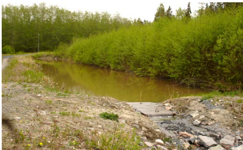
Figur 5-3. Rudimentdiket, norr om infartsvägen mot kärnkraftverket.
