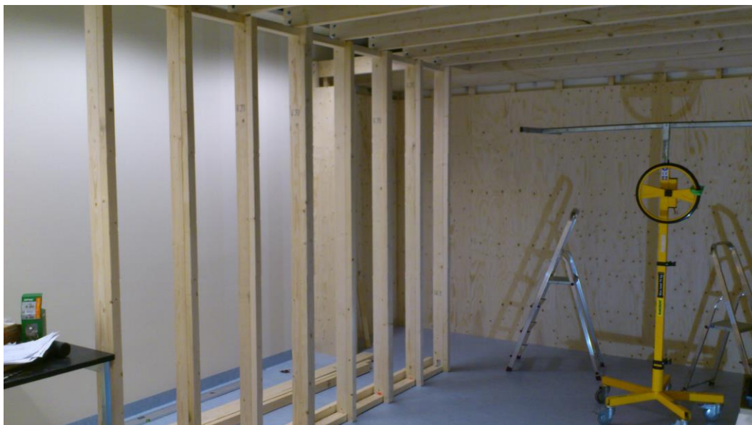
Figur 15. Stommen till det ekofria rummet byggs.
