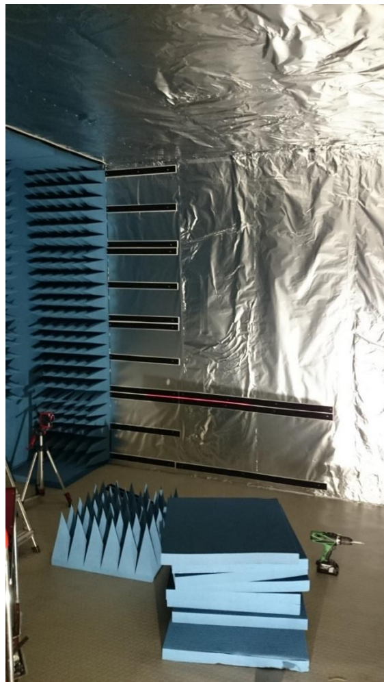
Figur 17. Radiovågsabsorbenterna fästs mot kardborreband som skruvats fast i väggen.
