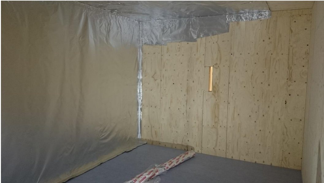
Figur 16. Aluminiumfolien på väggarna ger viss skärmning av radiovågor utifrån men syftet är att utgöra anpassning för att framförliggande absorbenter ska fungera optimalt.
