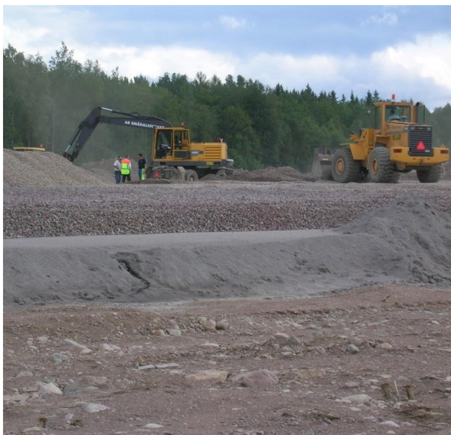
Foto från anläggande av bottenkonstruktion för deponi för farligt avfall i Högsby kommun.
