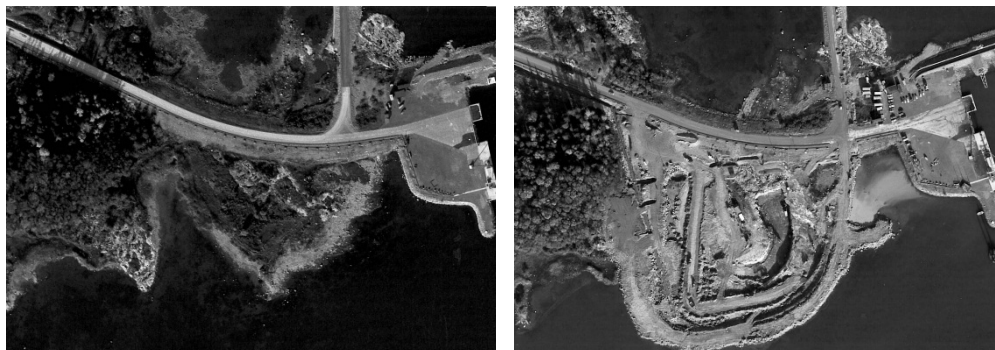
Figur 3. Bilder från uppförandet av den befintliga SFR-anläggningen. Bilden till vänster visar Stora Asphällan oktober 1982, bilden till höger visar samma område oktober 1983.
